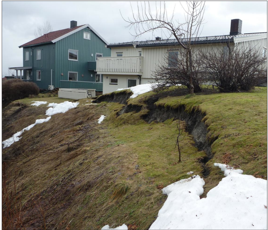
Utglidning i leirskråning og fylling i Byåsen, Trondheim. Mars 2012
