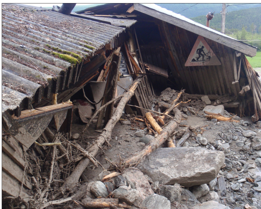
Skader etter flomskred juni 2011
