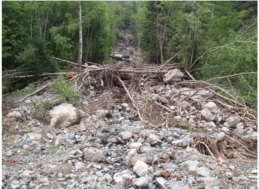
Flomskred, grovsortert avsetning med store steiner på overflaten og vegetasjon
